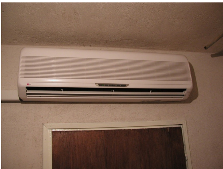
Slika 14. Klima uređaj za hlađenje u prostoriji za zrenje sira(izvor: S. Kalit)
